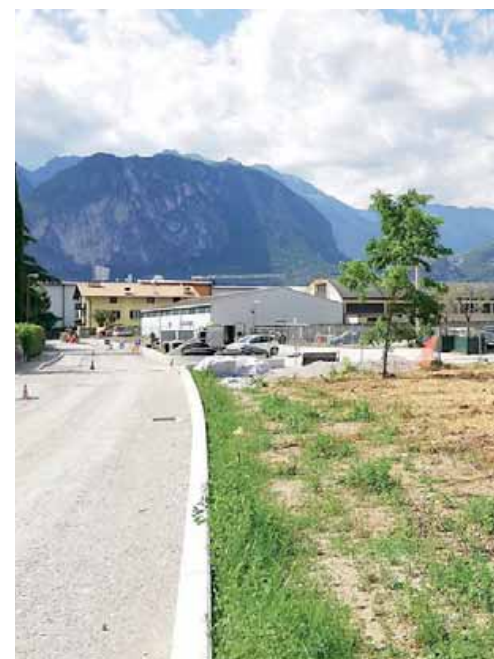
Lavori in corso in via Treviso
